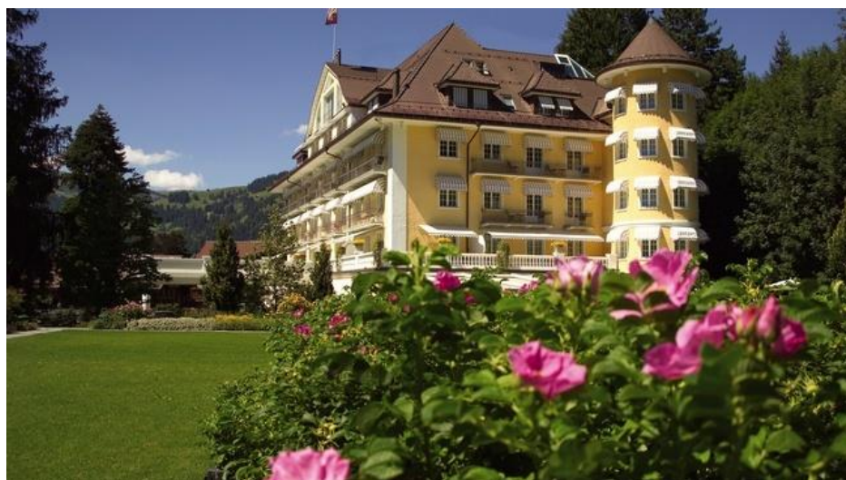
Hôtel du Mont-Blanc à Annemasse – Haute-Savoie – France
