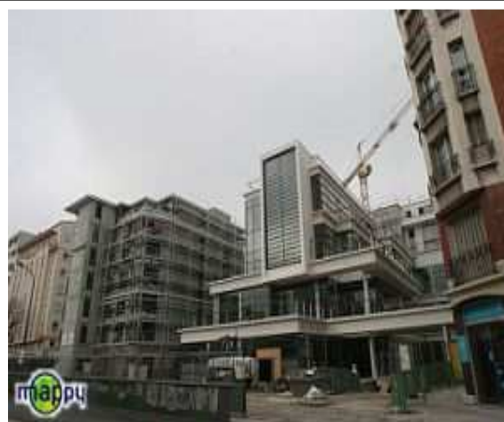
Photo des travaux en cours
